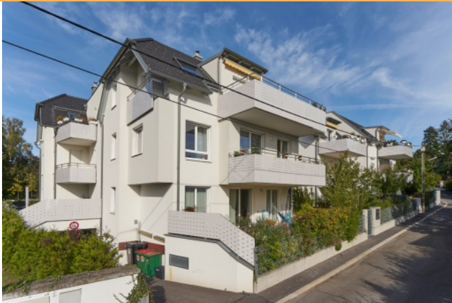
Wohnhaus Wien 14, Keilstraße 3-5 Eigentumswohnungen / Tiefgarage
